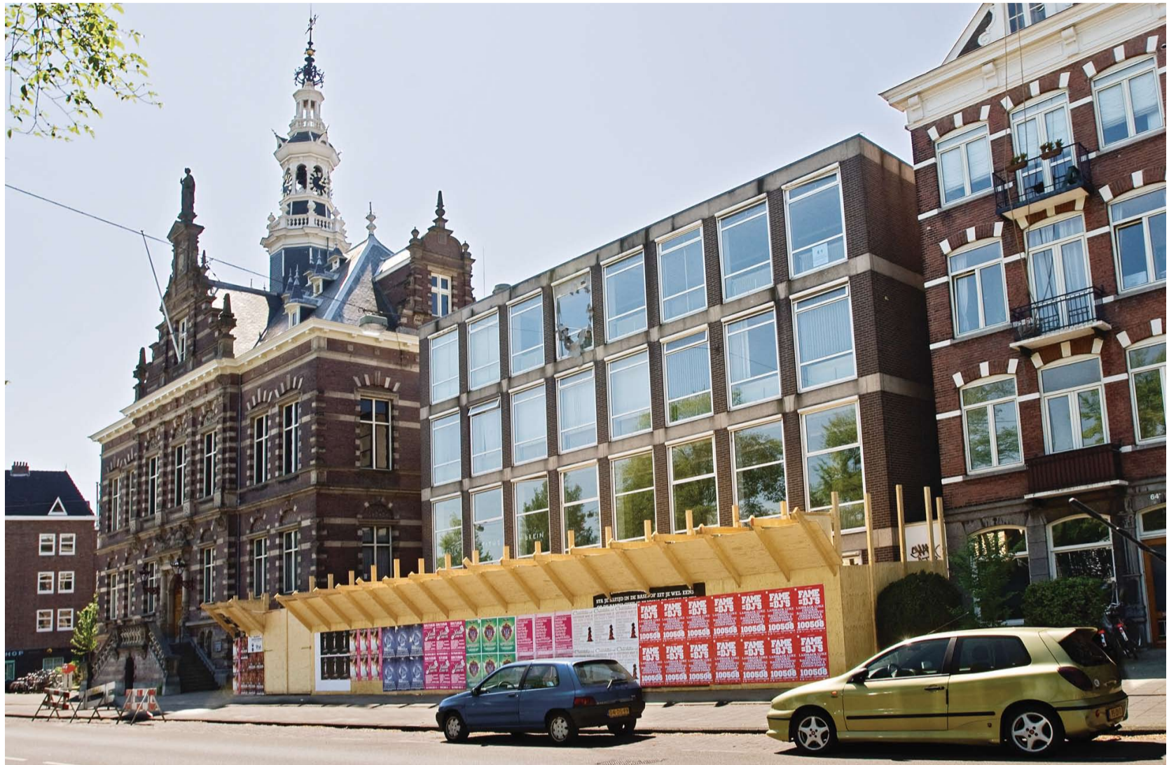
Het Archiefterrein: klaar voor de sloop. (foto: Peter Lange)
